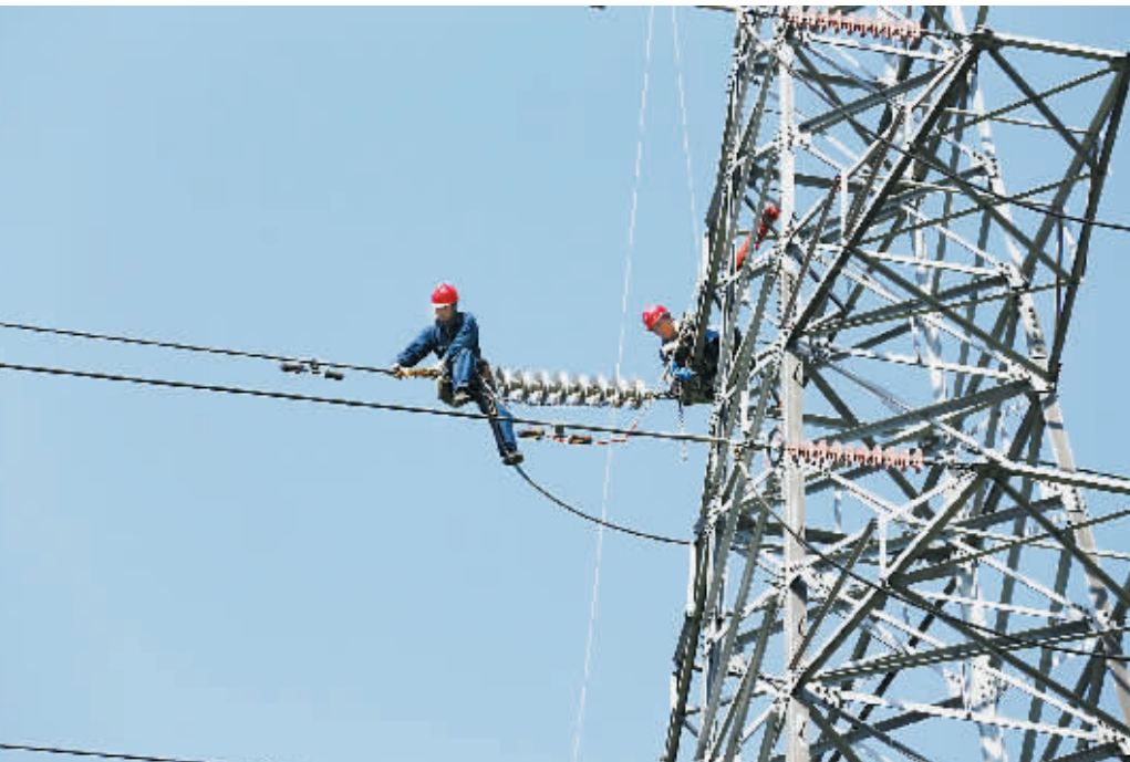
110千伏宝滨线是110千伏滨湖变电站的电源线,全线42基杆塔,因地势较高,又处于雷区,线路原来使用的陶瓷绝缘子极易受污染和覆冰,影响线路抵御灾害天气的能力及可靠供电。10月12日至13日,信阳供电公司线路检修人员利用秋季检修的机会,将其中有8基耐张杆塔的48组绝缘子全部更换完毕。 甘仁伟 刘 威 甘一泉 摄
