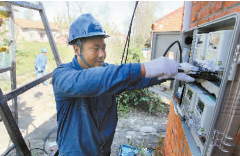
日前,潢川县供电公司员工对甲塘村进行智能表改造工作。据悉,该公司今年共有15000只智能表推广和2116台专公变全覆盖的建设任务,工程完成后将为下一步智能表全覆盖工作奠定坚实基础。因为工作人员进行智能表安装工作。 杨 君 摄
