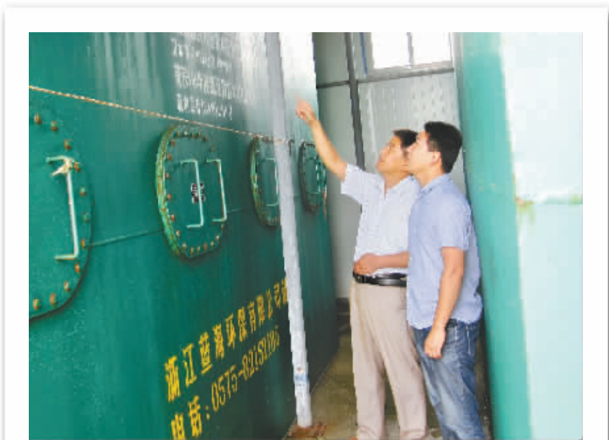
近年来,淮滨县审计局高度重视农村安全饮水工程跟踪审计。今年,该县农村安全饮水投资6292万元,共涉及13个乡镇79个行政村,解决13.6万人安全用水问题,有效促进农村生活环境的改善,被群众称为“暖心工程”。图为该局审计人员在核查安全饮水设备的过滤性能。
