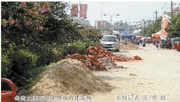
新街大道花坛旁堆放的建筑物。 本报记者 张勇 摄
