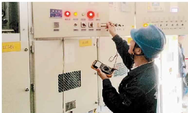
近日,信阳供电公司对于三里桥乡生命阳光城小区主要配电设备交接试验,通过高压试验采集设备运行数据,对设备投运进行最后的严格考核。图为供电员工正在采集设备数据。 杨帆 梁翼 摄
