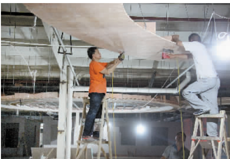
图为工人正在做家装4.0体验馆大厅组合吊顶。
