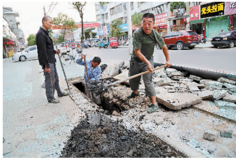
连日来,淮滨县利用雨季后歇期,对全县防汛隐患、群众救助情况等摸排,对排查出的隐患进行整改,以应对未来可能出现的险情。图为昨日该县城区清淤现场。宋同杰 杨德政 摄
