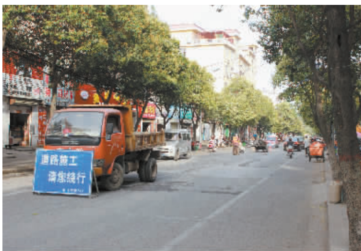
图为建设东路维修现场。
