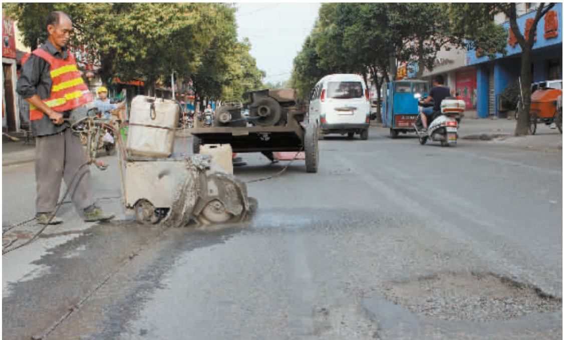
图为施工人员正在切割破损路面。
