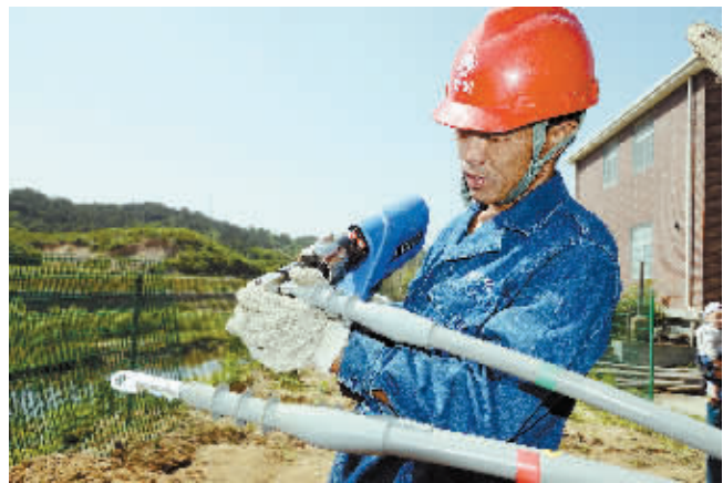
5月12日,在新县城南大花园内,新县电力员工正在全力抢修因用户施工不慎挖断的地理电缆。 陈巍 摄
