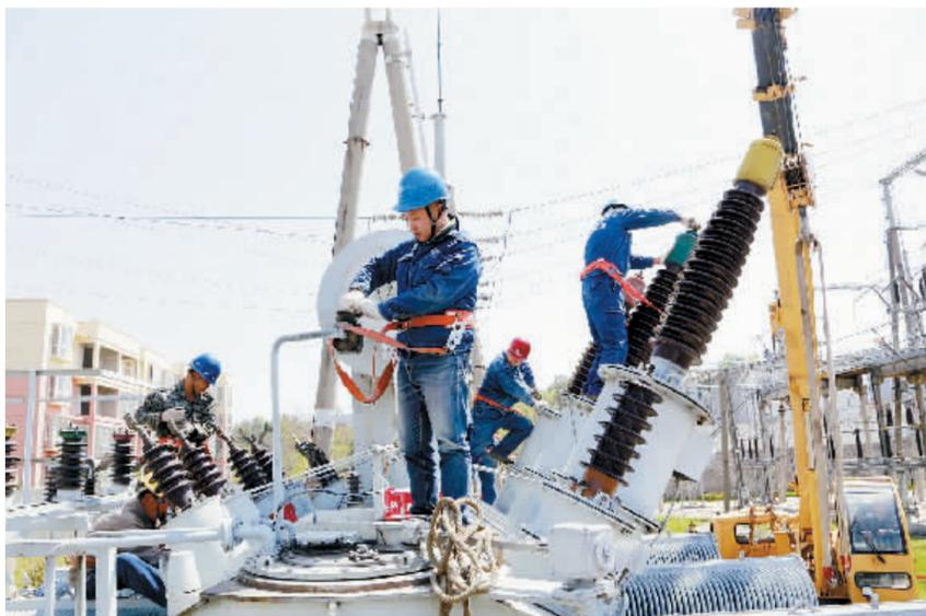
4月15日上午,信阳供电公司110千伏宝石桥变电站内1号主变压器进行维修。据悉,该变电站建于1992年,担负着信阳市区的供电任务。此次维修是为了保证该变压器在夏季用电高峰期间能够正常工作,以免造成长时间大面积停电。图为市供电公司变电检修人员对该站1号主变压器进行检修时的场景。
