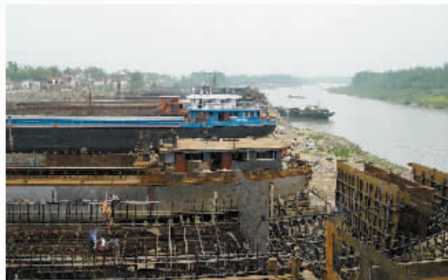
淮滨县造船企业正在进行船体组装
