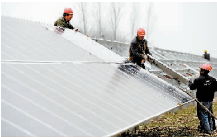
3月23日,工人在河南兰考县谷营乡黄河滩区搭建光伏发电板。据介绍,兰考县规划建设一期光伏电站工程500MW,其余300MW预计将于2015年年底完成主体工程建设。新华社记者 李安 摄
