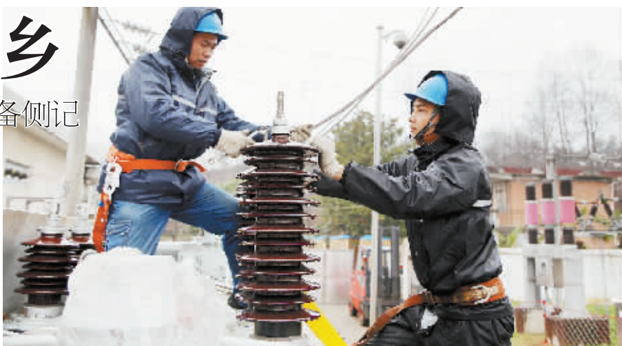
图为信阳供电公司工作人员正在冒雨更换变压器。 刘威摄
