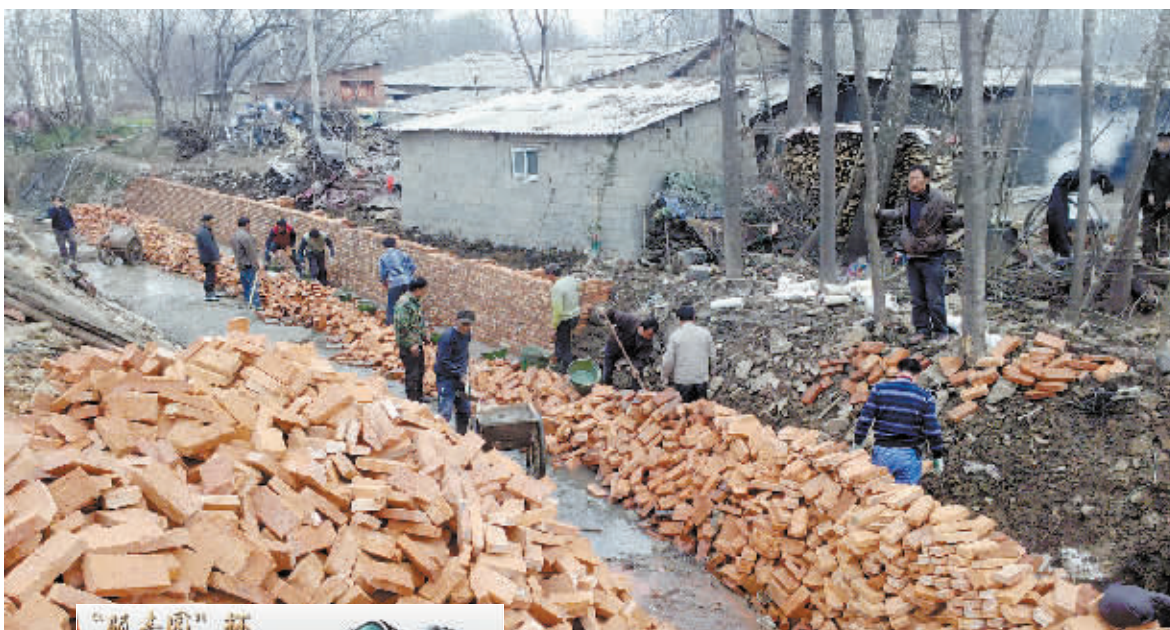
连日来,浉河区抢天夺时,集中开展内河清淤治理工作。图为浉河区组织人员在中心城区西村修建河道及护坡时的场景。 刘文强 吕本杰 摄
