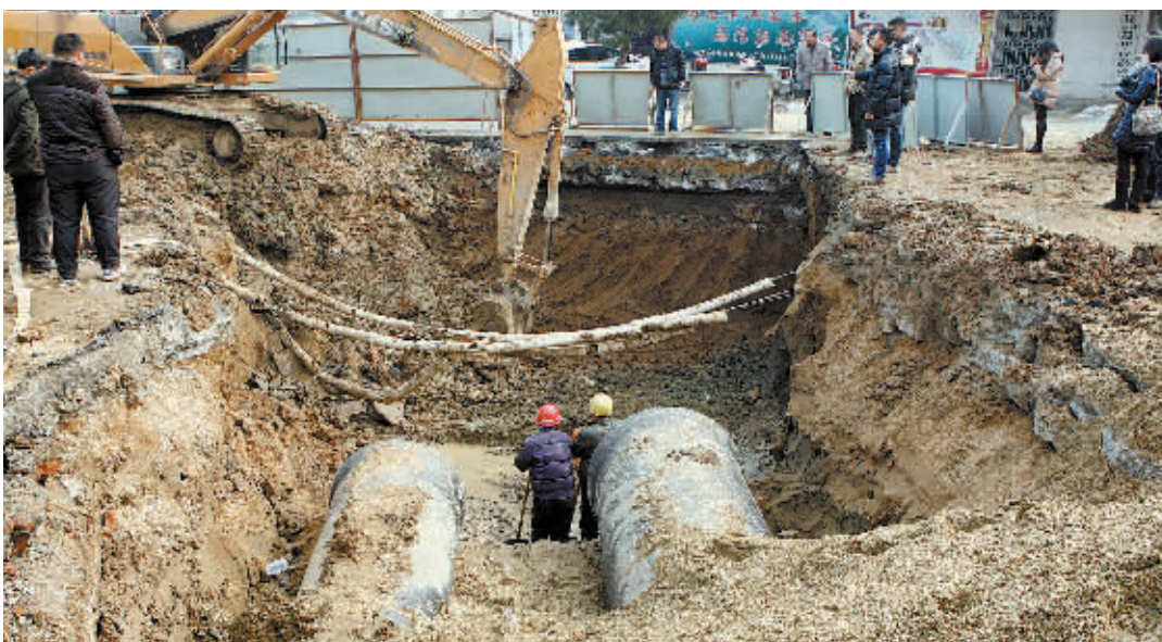
图为南湾水厂输水管道改造施工现场。
