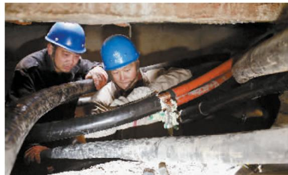
2月7日,在市羊山新区新七大道上,信阳供电员工接入新投运的电缆,调整电缆运行方式,该公司提前敷设一条2千米的电缆,新增两台环网柜,使担负信阳市区供电的曾家园变电站、羊山变电站、侯家湾变电站3座110千伏变电站都能相互倒通,大大增加低压调度的灵活性,显著提高供电可靠性。图为供电公司员工正在电缆井下作业时的场景。
