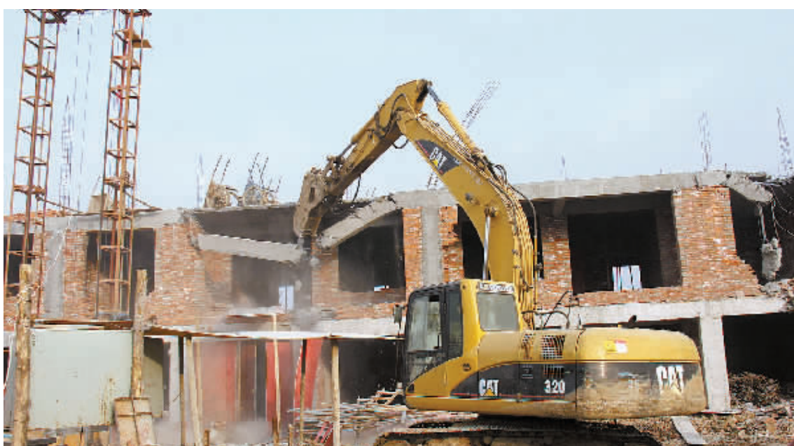
为认真落实市“三违”集中整治工作会议精神,昨日,平桥区“三违”整治办对位于光南路东西两侧4处“三违”建筑进行拆除。图为拆除现场。翟阳 摄
