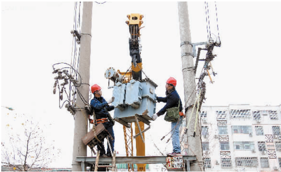
1月15日,光山县电业局施工人员顶着严寒,对位于县城中心繁华地带的黄金公司台区、龙堤台区、武装部台区进行调整增容工作,确保春节期间稳定可靠供电。甘宇 摄
