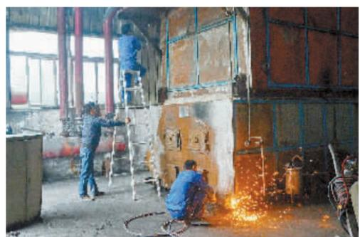
1月11日,平桥区一家公司的1台4蒸吨燃煤锅炉正在被拆除。2014年,我市拆改燃煤锅炉64台,超额完成省政府下达的53台年度燃煤锅炉拆改任务,年可减少燃煤量约2.3万吨。2015年,我市将继续大力推进建成区和各县域的燃煤锅炉拆改工作。 本报记者 郭靖 摄
