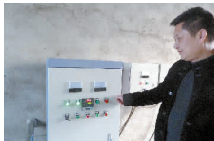
1月8日,罗山县高店乡集中供水工程主管道和分支管网铺设完成,入户工程进入扫尾阶段。2014年,罗山县投资2207万元兴建农村饮水安全工程,仅高店乡集中供水工程就可解决万余人的饮水安全问题。图为工作人员正在调试水厂自动变频控制器。
