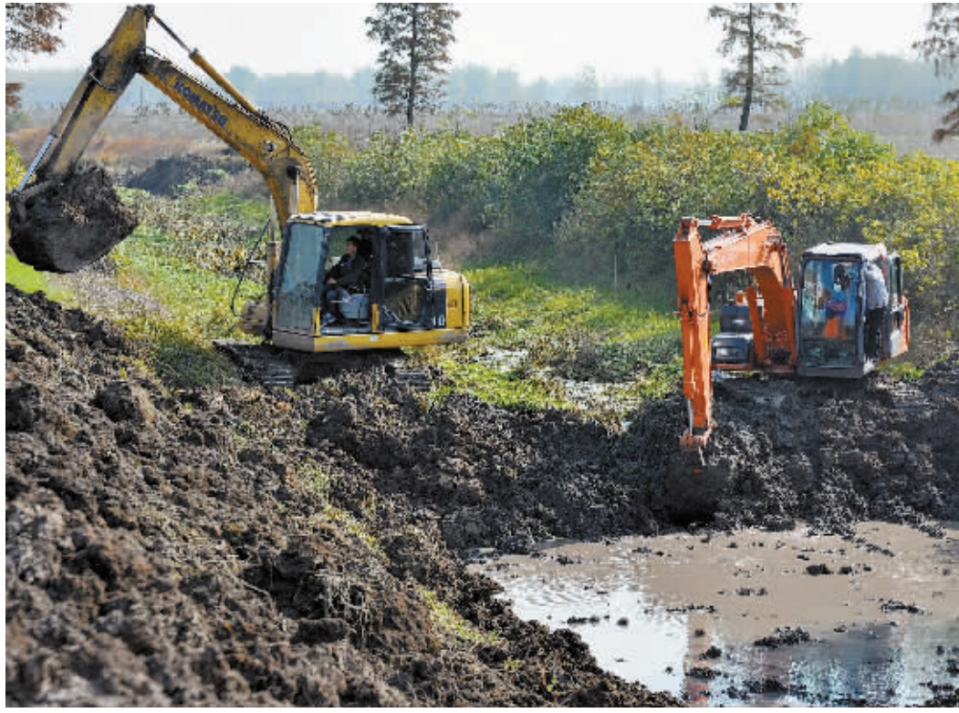
近期,息县抓住有利天气时机,大力推进冬季农田水利基本建设。截至目前,全县已完成坑塘改造180多口,整修机电灌站16处,整修灌排渠道160多公里,新打机井300多眼。图为12月26日,息县包信镇一施工现场正在作业时的场景。 徐维摄
