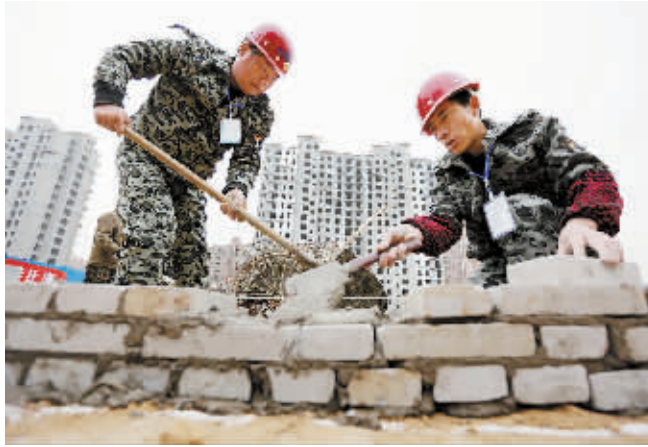
12月11日,工人正在进行砌筑标砖比赛。当日,河南省焦作市武陟县住建局举办了一场建筑工人技能比赛。比赛分为钢筋绑扎、砌筑标砖、挖掘土方等6项内容,共有5家施工单位的80多名选手参加。比赛旨在提升建筑行业一线人员的综合技能,提高建筑施工质量。新华社发(冯小敏 摄)
