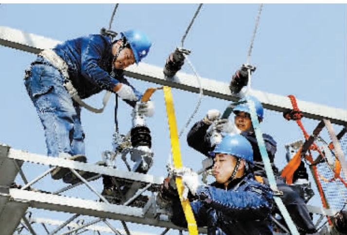
12月10日,固始县电业局工作人员对柳村35千伏变电站12组10千伏隔离开关进行更换,提高设备稳定运行水平,为即将来临的冬季用电高峰做好准备。高伟 摄
