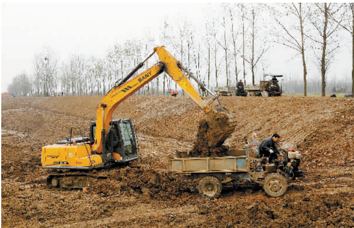
潢川县早谋划、早动员,抢天夺时积极推进今冬明春农田水利建设工作。图为12月3日,潢川县魏岗乡高楼村南陈营万亩大塘正在开挖清淤,整修土方达18500立方米,竣工后可增加蓄水量3万立方米,保障南陈营村民组429亩土地农业灌溉用水。
