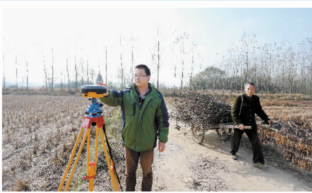
出山店水库开工在即。日前,河南省水利勘测有限公司技术人员在平桥区甘岸办事处孔庄村淮河边对导流渠控制点坐标进行GPS测绘。平桥区甘岸办事处孔庄村村民也忙着做清理准备工作。本报记者 秦旭 摄
