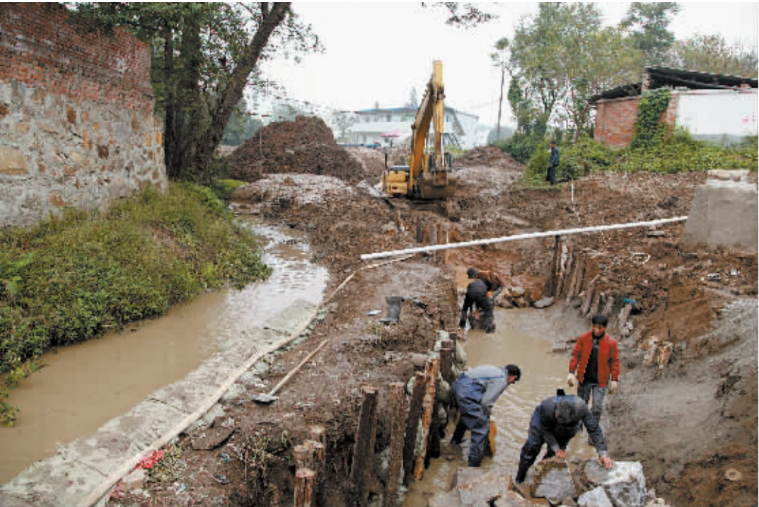
连日来,浉河区湖东办事处抢抓天气晴好的有利时机,全力配合市内河治理办,强力推进湖东沟和三里店内河整治。图为整治现场。陈云啸 摄
