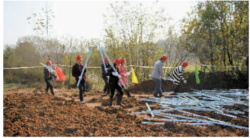
图为记者帮助电力工人搬运铁塔金具时情景。 见习记者 张馨月 摄
