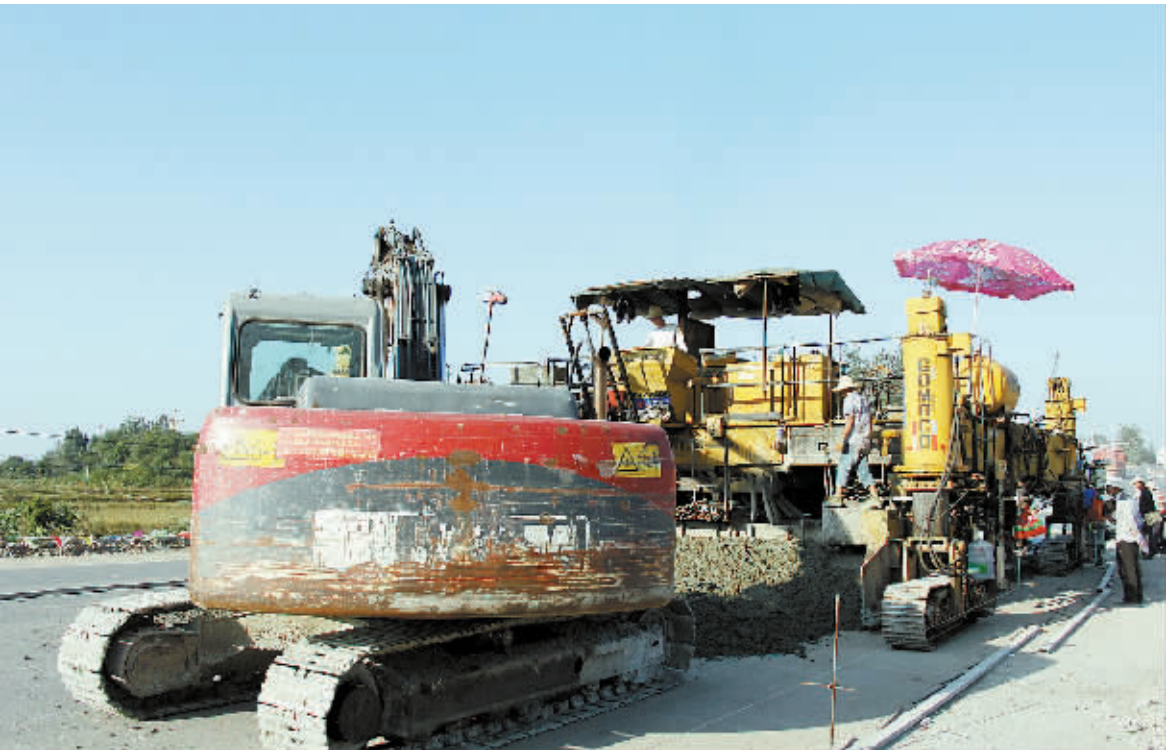
G312线罗山县城至信阳市区段一级公路改建工程是今年省、市重点工程,项目全长51.03公里,设计路基宽24.5米,路面宽20米,按双侧对称加宽,双向四车道一级公路标准改建。项目开工建设以来,承担该项目三标段施工任务的平桥区交通管理部门不断强化措施,科学组织施工,工程快速推进。图为摊铺机正在进行混凝土铺筑施工作业。
