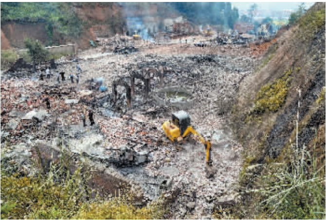
9月23日中午,记者从湖南醴陵市获悉,浦口镇保丰村南阳出口烟花厂爆炸事故造成死亡的人数已达13人,还有1人失联,33人受伤。9月22日15时许,南阳出口烟花厂发生爆炸。图为爆炸事故现场,挖掘机在清理废墟。
