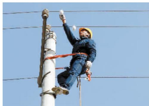
为有效降低配网故障率,淮滨县电业局利用秋季配网负荷较轻的有利时机,对配电线路、设备和台区进行一次全面普查,集中消除设备缺陷,持续提升供电可靠性和供电服务质量。图为昨日该局员工对10千伏淮滨线加装驱鸟器和故障指示仪,确保线路正常运行。
