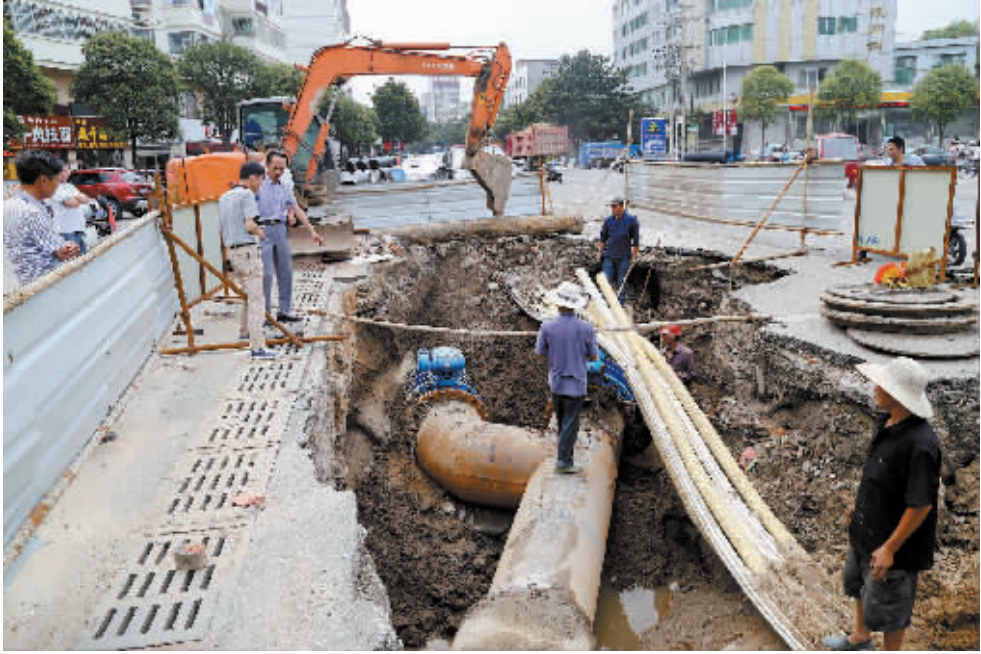
市供水集团公司组织人力、物力、财力,全力做好东方红大道供水管网改造工作,为城市安全供水和东方红大道综合改造工程的顺利竣工作出了积极贡献。
