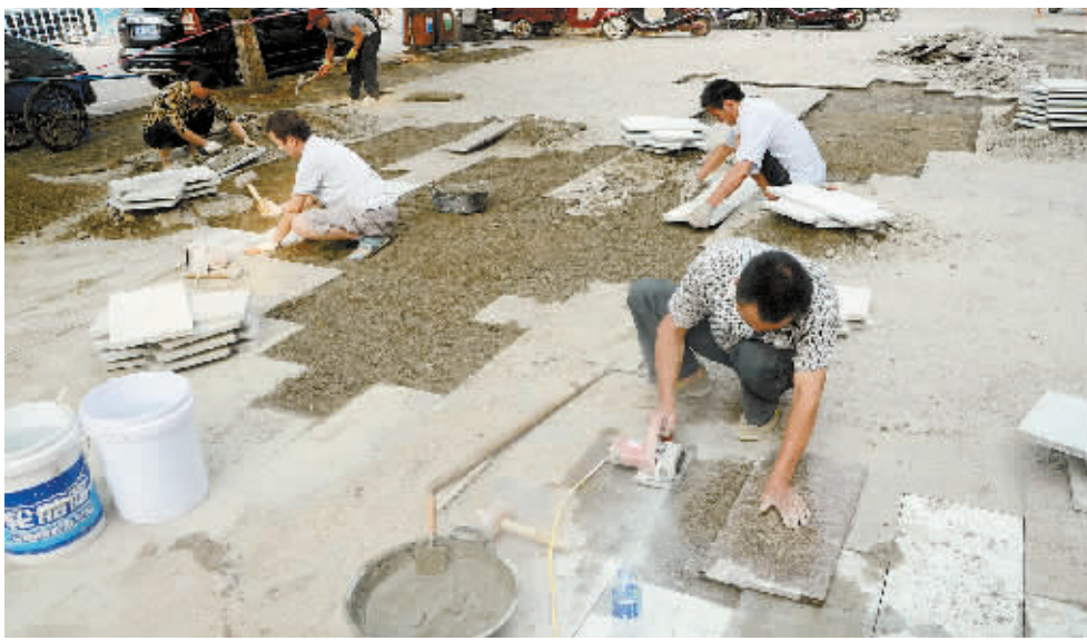
8月26日上午,记者在市区中城大道东段阳光新村附近看到,施工人员正在整修人行道。据了解,为方便广大市民出行,近日,浉河区市政管理执法局对辖区部分破损的路面进行整修。像这样整修的还有新马路、新华东路、广场路等路段。
