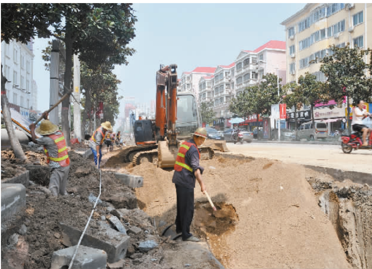
昨日,记者在东方红大道综合维修改造工程施工现场看到,施工机械来回穿梭,施工人员挥汗如雨,一派火热的施工场景。据了解,该工程是2014年市政府十件实事之一,改造后将全面提升道路通行能力,方便市民出行。
