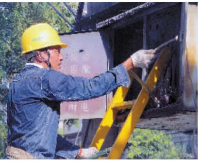
昨日,骄阳似火。在淮滨县电业局南城供电所,抢修人员正在对金湾3号配变损坏的低压负荷开关进行抢修,确保居民用电。李坤摄
