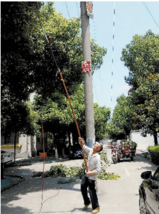
夏天大树枝叶繁茂,给人们带来清凉的同时,也对附近电力设施的安全运行构成威胁。图为昨日上午,浉晓新村物业处的园林工人正在锯掉小区内影响供电安全的树枝。
