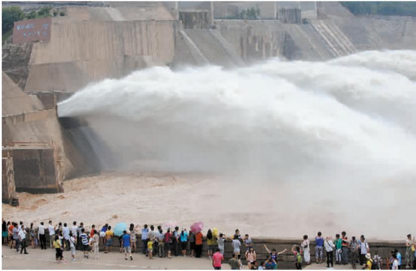
6月30日,游客在黄河小浪底水利枢纽工程观看飞瀑景观。当日,2014年黄河小浪底调水调沙正式开始。本次调水调沙将实施黄河万家寨、三门峡、小浪底3座水库水沙联合调度,将黄河下游主河槽的过流能力提高,利用“人造洪峰”将下游河床淤积的泥沙送入大海,同时减少小浪底水库的泥沙淤积。自2002年开始,黄河小浪底水库已实施14次调水调沙。新华社记者 朱祥摄
