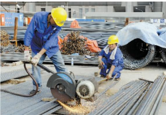
6月18日,在郑州地铁2号线黄河路站,中铁隧道局的工程人员进行切割钢筋作业。
