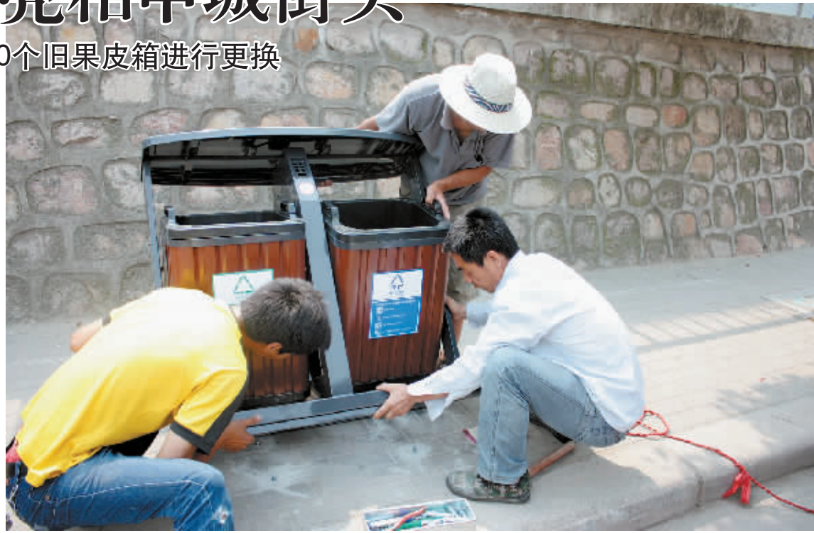
图为昨日施工人员在平桥中心大道更换新型果皮箱。
