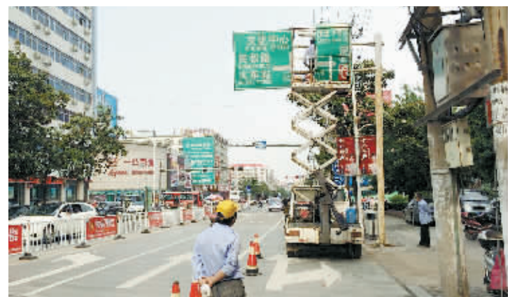
近日，市交警支队组织相关工作人员，对我市破损的道路指示牌统一进行了更换、修补。图为东方红大道一处施工现场。
