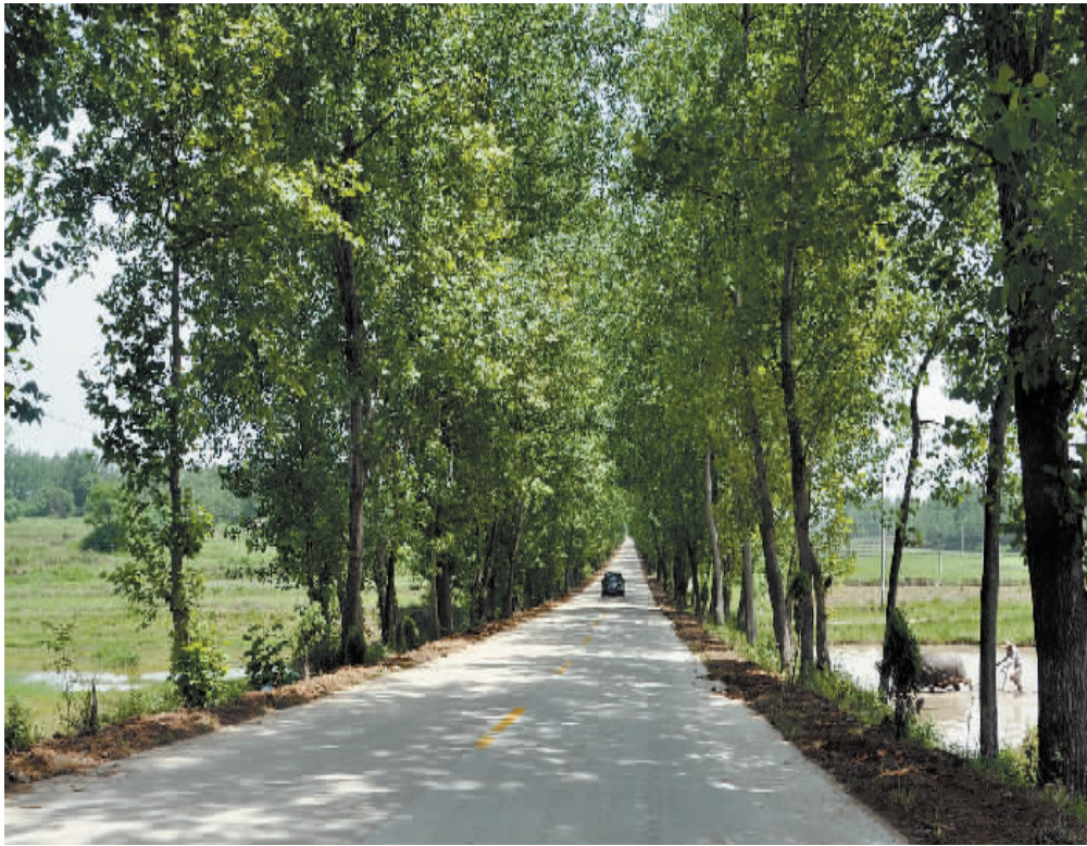
近年来,平桥区交通运输局在全力推进农村公路建设的同时,结合全省农村公路“好路杯”竞赛活动,积极筹措资金,开展“文明示范路”创建工作,全面提升全区农村公路整体形象,营造“畅、洁、绿、美、安”的农村公路环境,促进经济社会发展。截至目前,该局已创建“文明示范路”73公里。图为肖王乡至五里店办事处的“文明示范路”。 杨庆俊 摄
