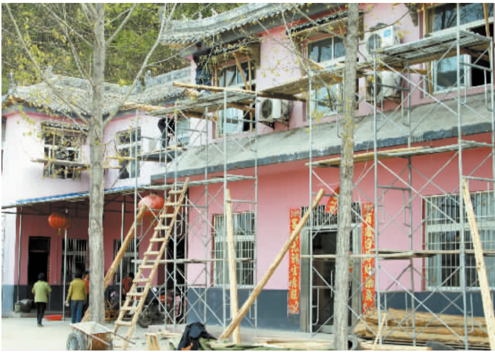
春茶采摘时节,很多外省市人到我市产茶乡镇购买新茶并观光旅游。连日来,我市沿环湖路各乡镇纷纷组织人员对临路建筑进行修整,树立信阳美好形象。图为浉河区谭家河乡沿环湖路一处建筑正在全面修整。
