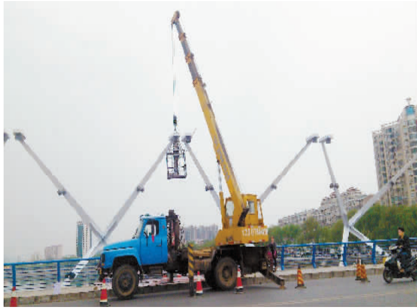
为了做好我市创卫工作,同时为了迎接第22届信阳国际茶文化旅游节的到来,近日,市政管理处组织工作人员对全市的桥梁进行刷新,图为上工人正在对大桥上的灯架进行刷新。 本报记者 孙浩然 摄
