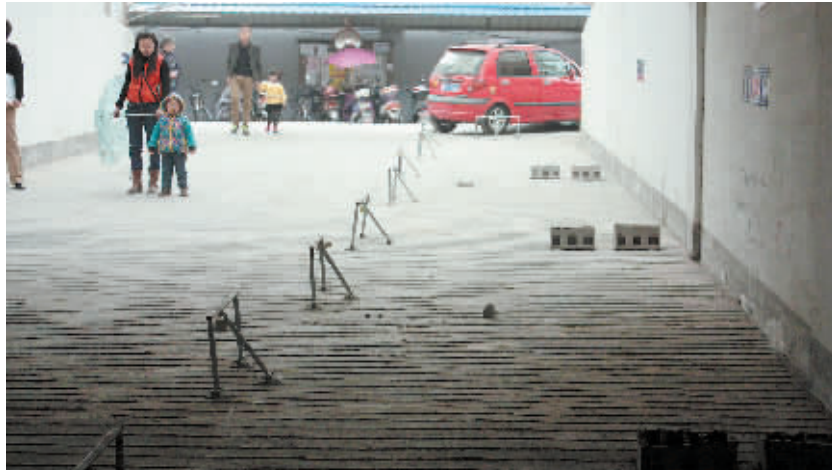
图为被占用的地下停车场行车通道。
