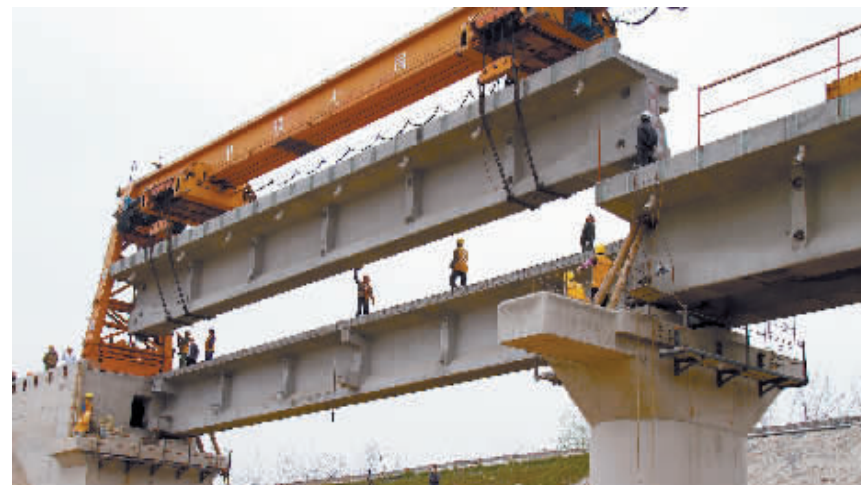
3月23日下午,随着最后一根箱梁和钢轨吊装成功,宁西铁路(复线)潢河特大桥顺利完成与西线铁轨合拢,标志着宁西铁路豫东南控制性工程主体工程完工。 肖乃宝 张灏 摄
