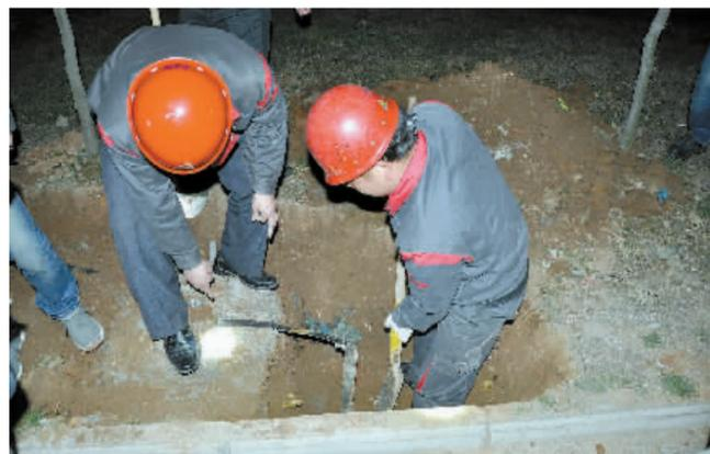
3月20日晚,羊山新区政和花园B区因施工单位违章作业,发生城网低压燃气管道泄漏。信阳富地燃气有限公司维修大队接到报警后,迅速赶赴现场,启动应急预案,在两小时内完成抢险抢修任务。图为抢修现场。刘凯 摄
