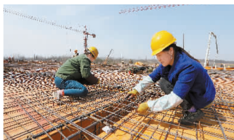
3月21日,信阳国际茶业小镇欧凯龙项目建设工地上,两位钢筋工正在认真施工。目前,信阳国际茶业小镇各施工单位抓住有利天气,增加施工作业量,加快建设进度,掀起施工高潮。本报记者 秦旭 摄
