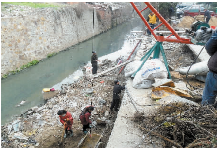
针对新中河部分河堤垮塌的问题,近日,浉河区老城办事处抢抓时机,投入人力、物力、财力对垮塌河堤进行修复,全面消除安全隐患,确保辖区河道畅通。
