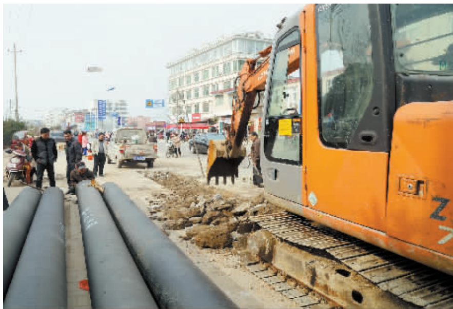
为深入开展党的群众路线教育实践活动,近日,市供水集团公司积极解决群众反映的供水问题,受到了市民的一致好评。图为十三里桥供水管网新铺工程施工现场。
