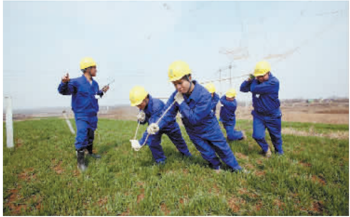
为加快推进信阳东500千伏输变电工程施工进度,施工人员发扬吃苦耐劳精神,加班加点奋战在施工一线。图为3月9日,信阳供电公司输电运检专业运维班对新建500千伏线路跨越处进行放线。
