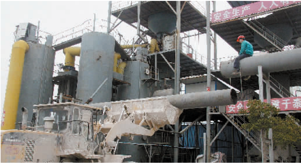
为积极响应国家节能减排号召,减少有害气体排放,近日,息县海虹陶瓷有限公司拆除了对环境有影响的煤气发生炉,每年可少使用近万吨标准煤。同时,该公司购置了使用天然气的生产设备。图为该公司正在拆除煤气发生炉时的情景。
