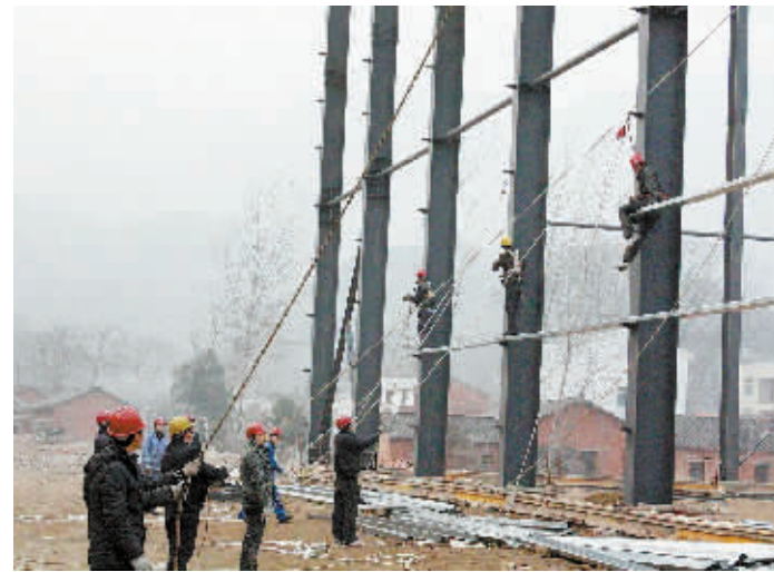
寒冬时节, 钧悦暖洋洋项目现场一派繁忙景象,工人们正在加紧建设厂房。该项目总投资1.6亿元,计划今年上半年投产,可年产2亿贴暖洋洋系列产品。
