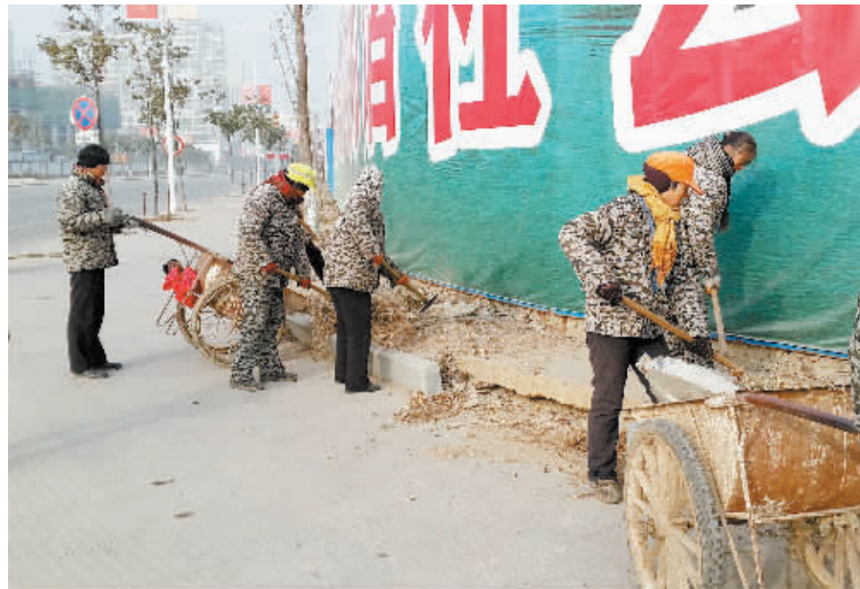
市中心城区环境卫生突出问题综合整治工作会议召开后,市城市管理综合执法局百花园区管理处迅速行动,组织力量对新八、新十、新十二、新十四等道路周边开展卫生整治,重点对部分新建工地外圈的建筑垃圾、绿化带垃圾、树穴杂草等卫生死角进行清理,进一步优化百花园区环境,提升城市窗口整体形象。 马涛 摄
