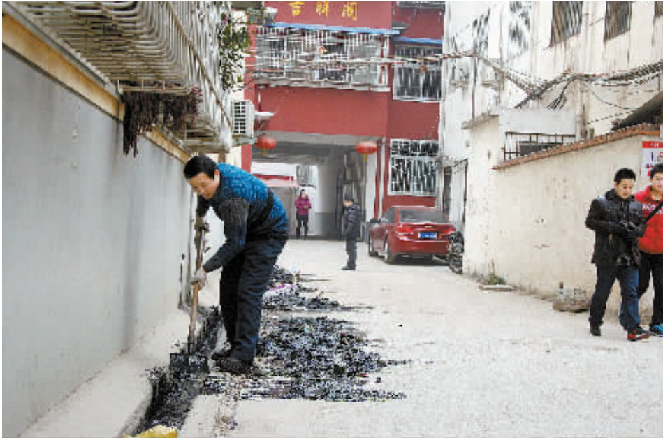
针对媒体曝光的原信阳砖瓦厂小区下水沟渠长期阻塞问题,昨日上午,浉河区五里墩办事处迅速组织人手对下水沟进行彻底清理,并将协调开发商为下水沟扣上盖板,以防再次出现淤堵现象。图为清淤现场。 本报记者 方慧玲 摄
