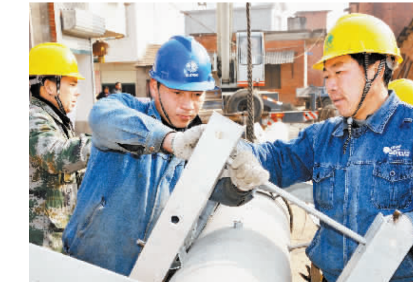
12月23日,固始县电业局员工对城区农场路10千伏线路进行改造,以提高该区域供电质量,保障用电客户在“双节”期间用电安全可靠。
