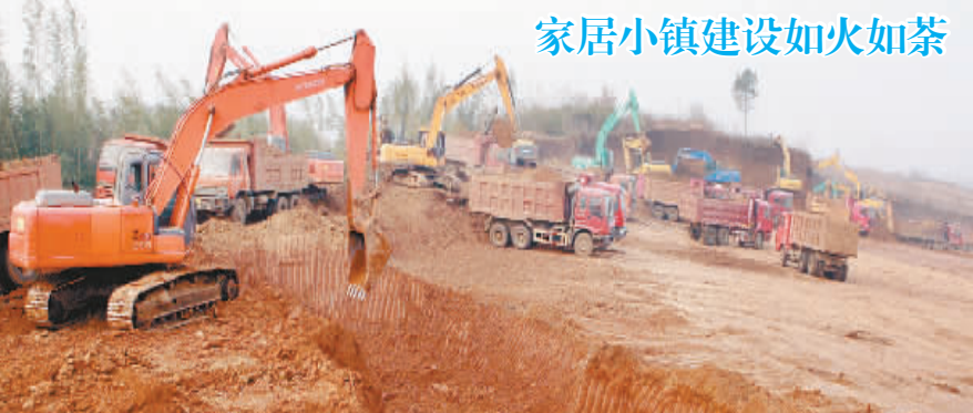
12月19日,信阳国际家居产业小镇建设工地,机器轰鸣,车辆穿梭,600多台大型机械正争分夺秒,日夜不停施工,一派繁忙景象。目前,首批签订入驻合同的15家企业已有3家进场建设。图为家居小镇施工场景。
